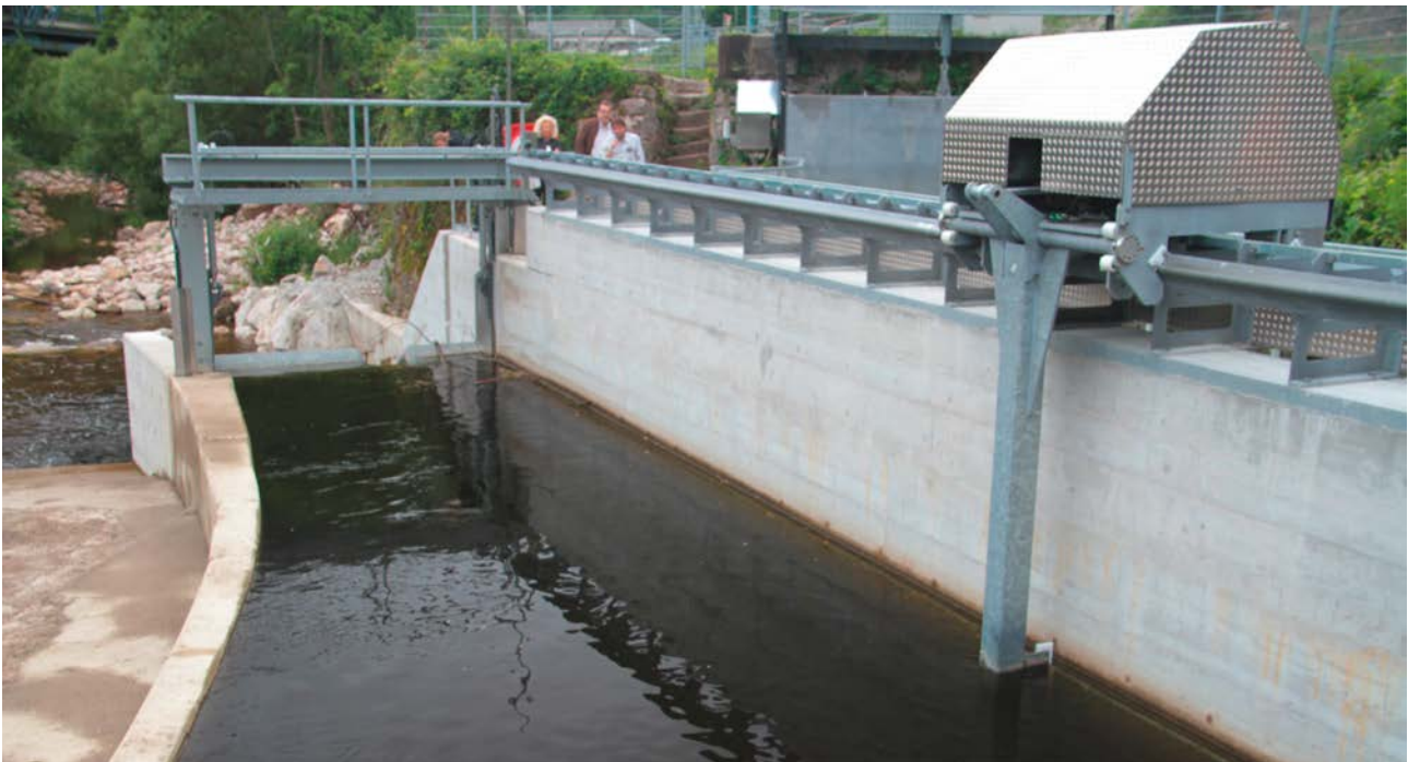
Abb. 4.3: Horizontalrechensystem mit Oberflächenabstieg an der WKA Katzwerke Murg, Weisenbach
