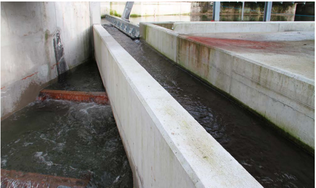
Abb. 4.12: Offenes Bypass-Gerinne wird über den Fischaufstieg geführt (ENCW, Nagold in Calw)
