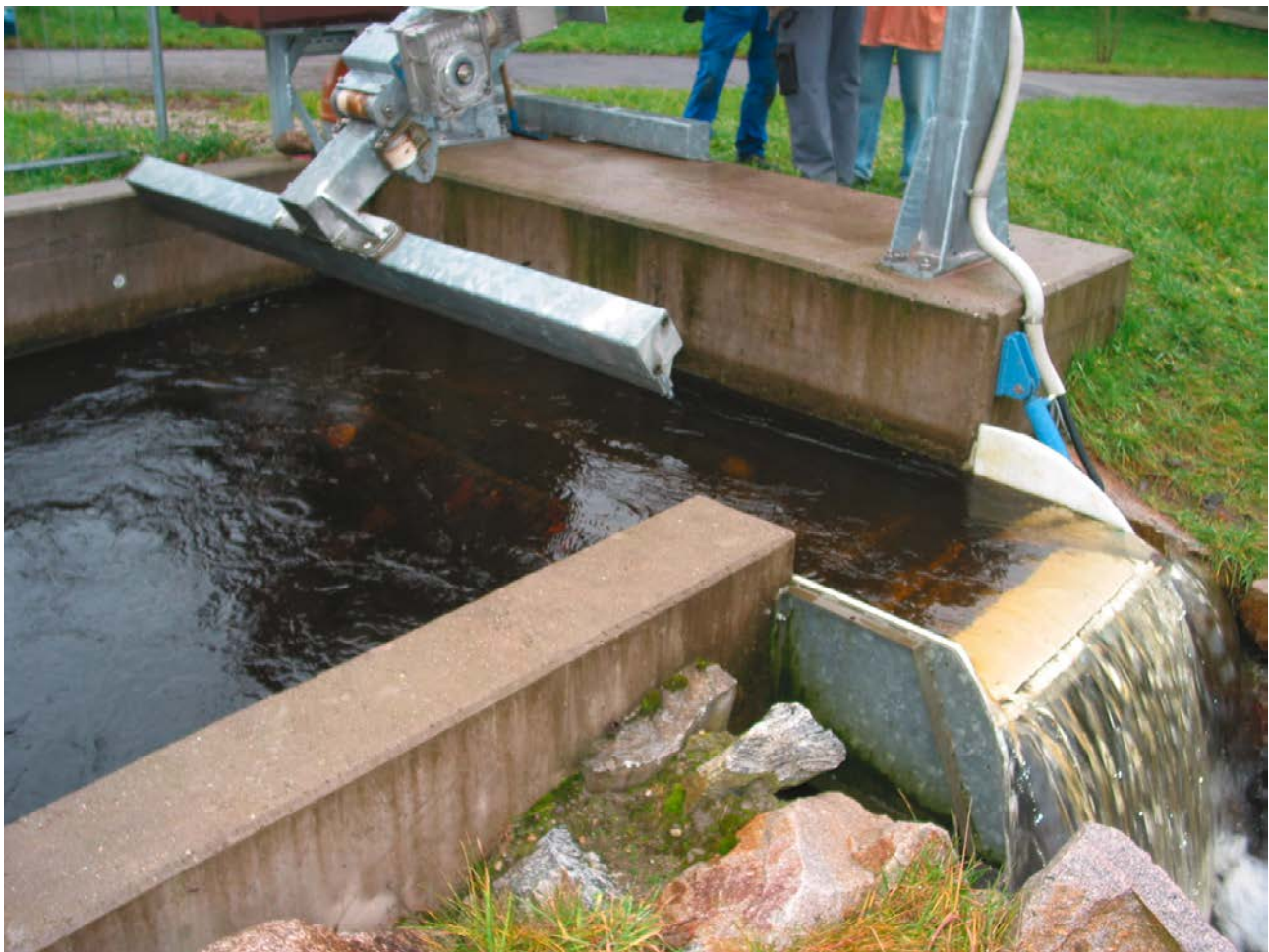
Abb.4.7: Seitlich angelegter Oberflächenabstieg an der WKA Winkelhof am Kraftwerkskanal der Wolf
