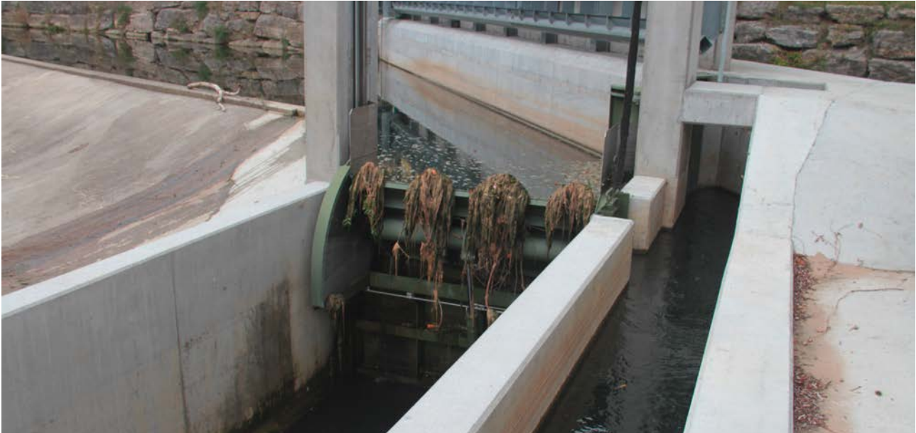
Abb. 4.11: Leitreechen-Bypass-System am Neckar bei Horb
