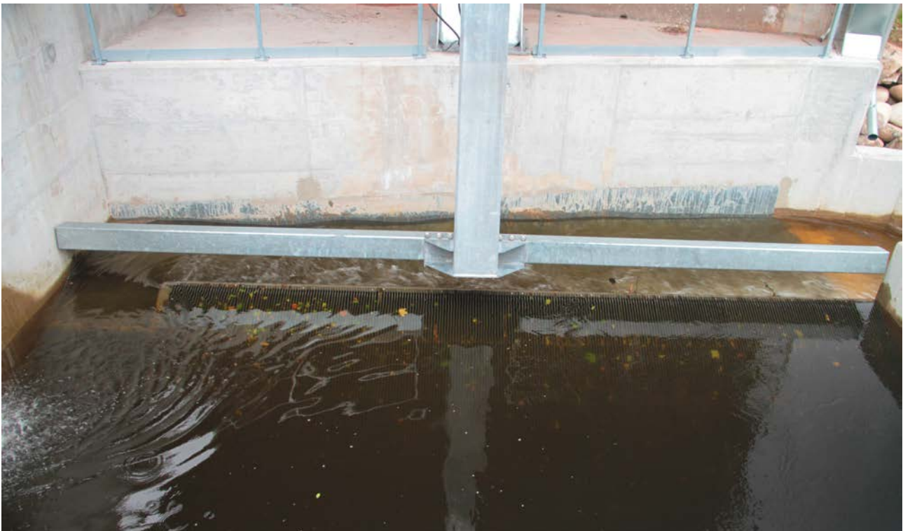
Abb. 4.9: Strömungsgünstige Einlaufsituation an einem Vertikalrechen ohne Verwirbelungen (Einlaufbauwerk linksseitig)
