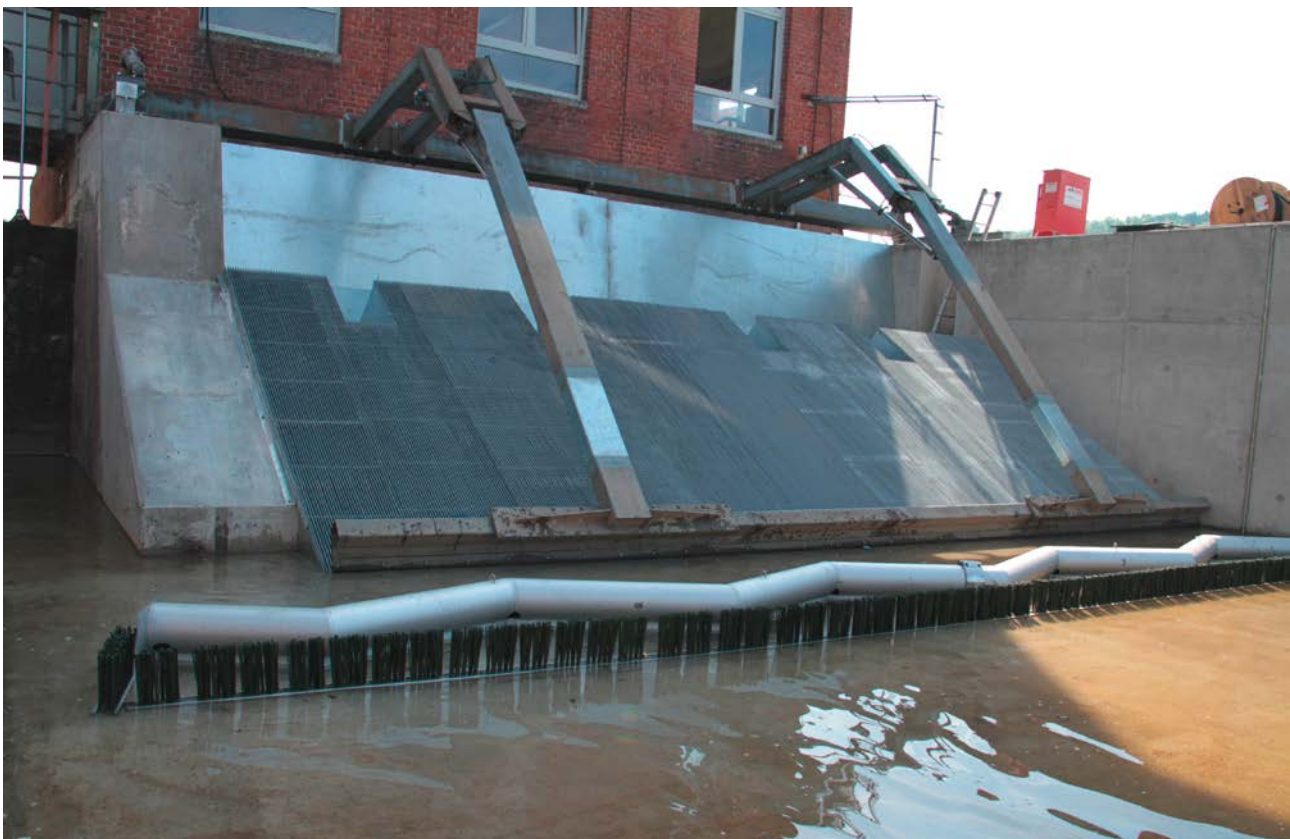
Abb. 4.5: WKA Lomersheim an der Enz: Vertikalrechen mit vier Einstiegen und sohlennem Bypass
