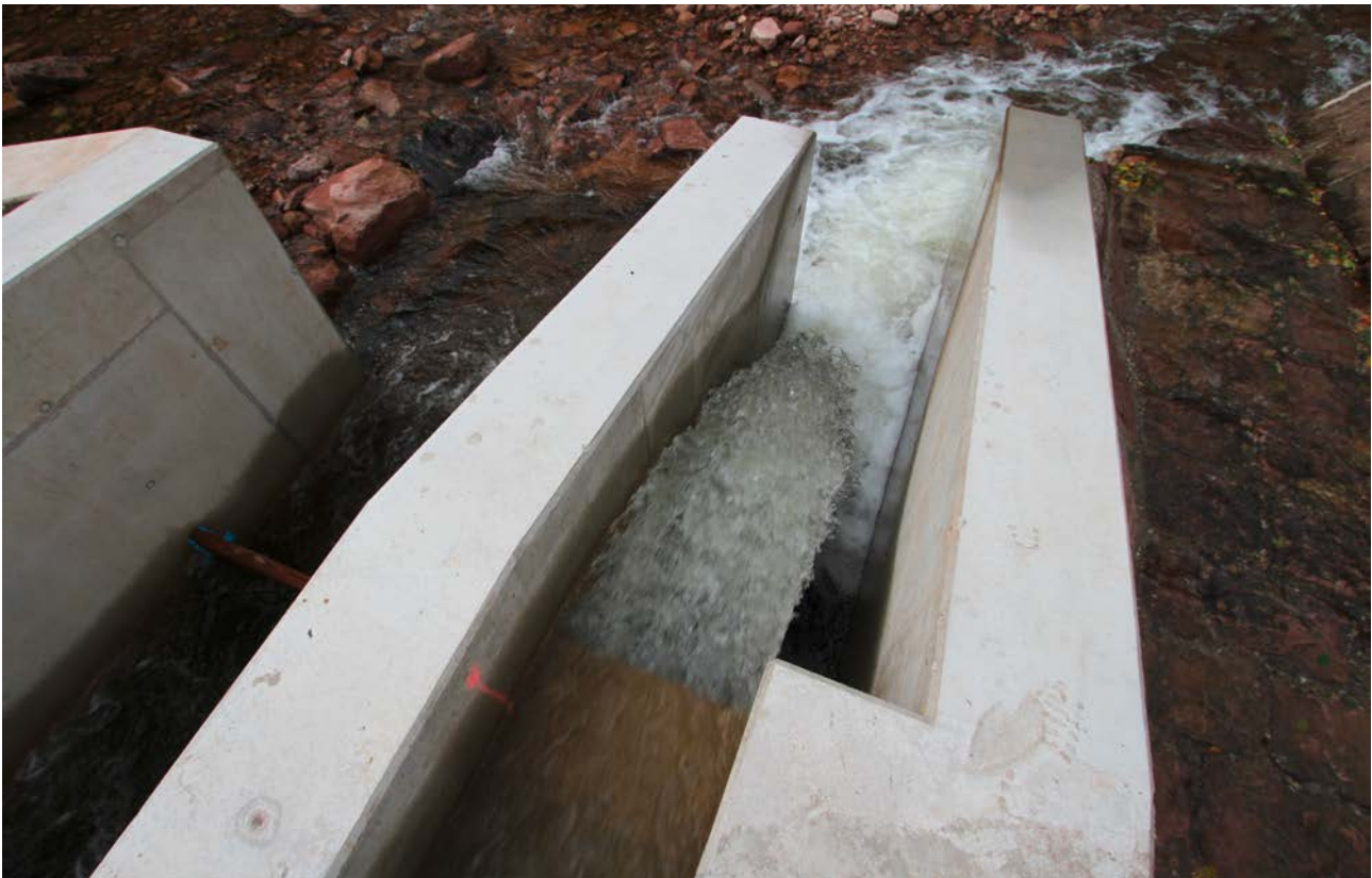
Abb. 4.13: Fischrückführung in kolkartigen Unterwasserbereich parallel zum Fischpasseinstieg (WKA Höfen, Enz bei Höfen)
